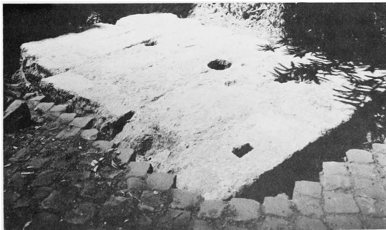
Fig.3. Braccio occidentale, parte delle fondazioni in tufo e travertino. Cfr. fig.4.
